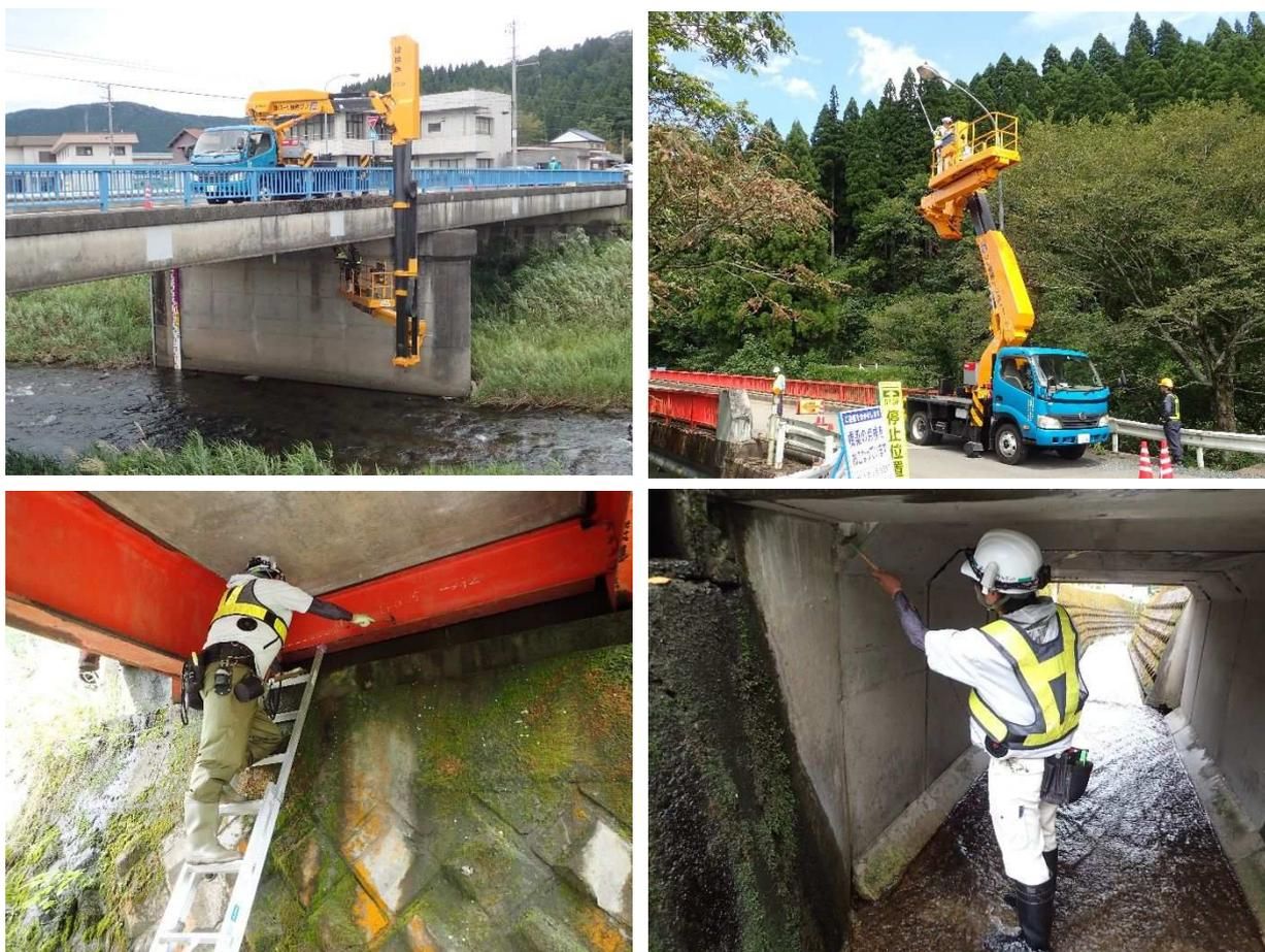
写真 3.1 近接目視による点検状況
