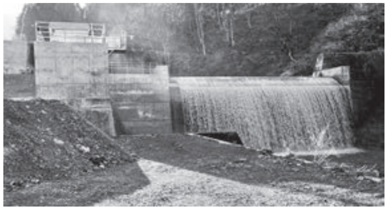
▲水海小水力発電所(取水部)
