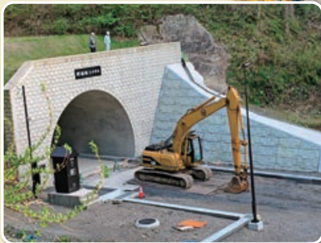
▲新板垣トンネル工事状況(越前市側)
