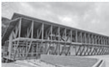
▲道のオアシス センターハウス
