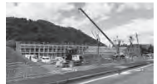
▲整備が進むフォーシーズンテラスの工事現場の様子
