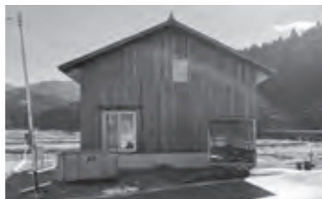
▲水海地区の町営住宅
