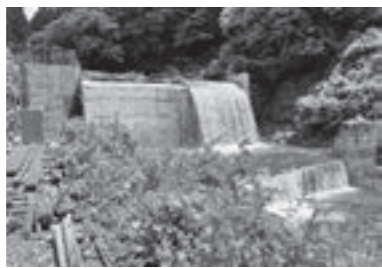
▲小水力発電取水口
