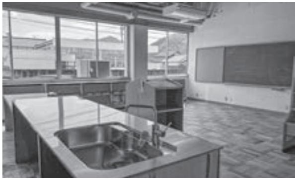
▲開発センター改修工事の様子
