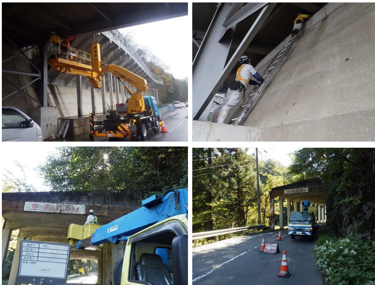
写真 2.1 近接目視による点検状況
